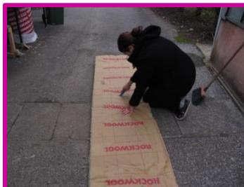
On découpe la laine de roche et on pose l'isolation au mur.
